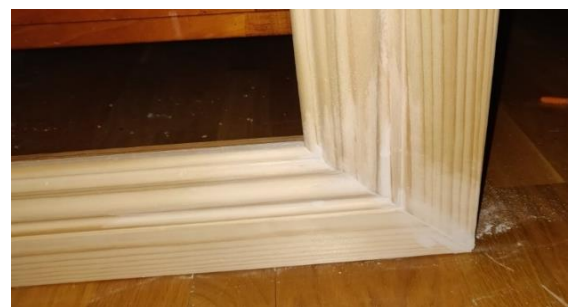
Figur 8 visar att det är nödvändigt med att slipa bort det överflödiga spacket.
